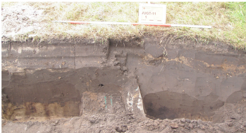
Afb. 2. Weergave van de aangetroffen leidingen in het eerste gedeelte van de proefsleuf.
